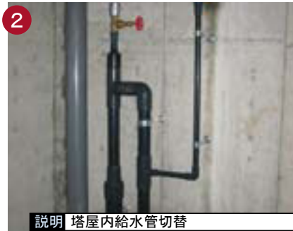
説明 塔屋内給水管切替
