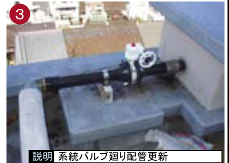
説明 系統バルブ廻り配管更新
