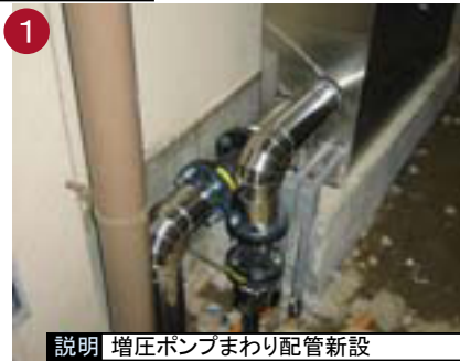
説明 増圧ポンプまわり配管新設
