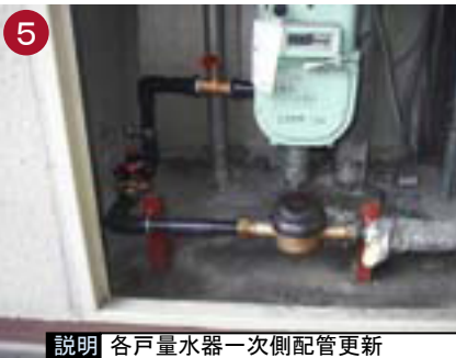
説明 各戸量水器一次側配管更新
