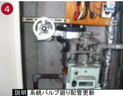
説明 系統バルブ廻り配管更新
